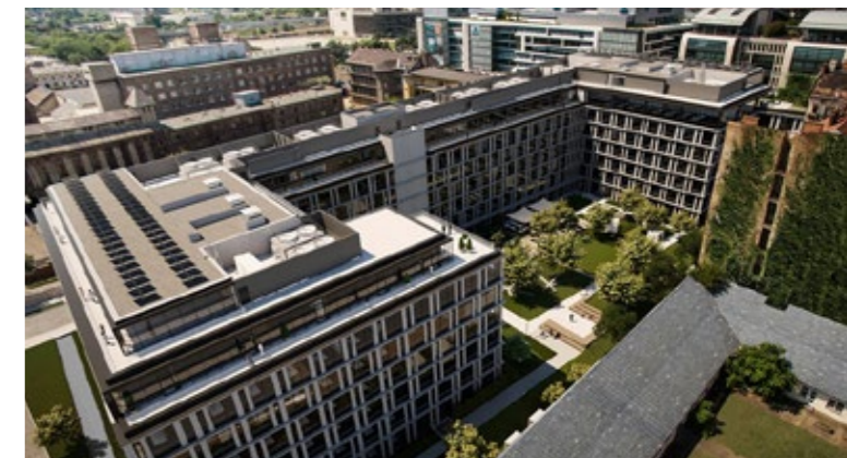
Mill Park, developer: Skanska
